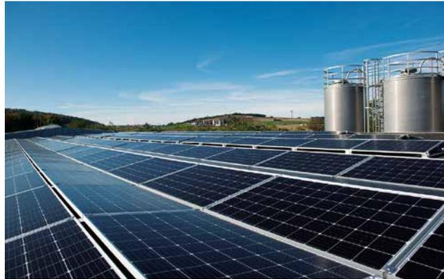
1.438 Solarzellen auf rund 3.600 m<sup>2</sup> Dachfläche decken bis zu 38 % des Strombedarfs am Produktionsstandort Würmla. Damit erspart Miraplast der Atmosphäre jedes Jahr 121 t CO<sub>2</sub>.
