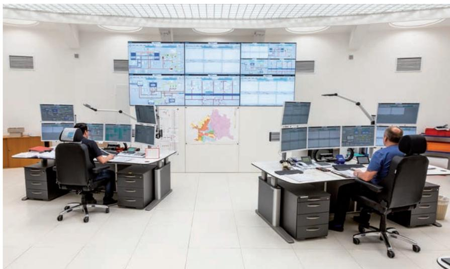
gungsnetz sowie sämtliche Anlagen und Kraftwerke entlang der I. und II. Hochquellleitung. Im Zuge der Arbeiten wurden auch die zugehörige Netzwerk- und Fernwirktechnik erneuert. In der Betriebszentrale von Wiener Wasser kommen sämtliche Messdaten und Informationen aus dem weit verzweigten Leitungsnetz zusammen und werden dort entsprechend verarbeitet. Die Inbetriebnahme der neuen Leitzentrale ist ein
